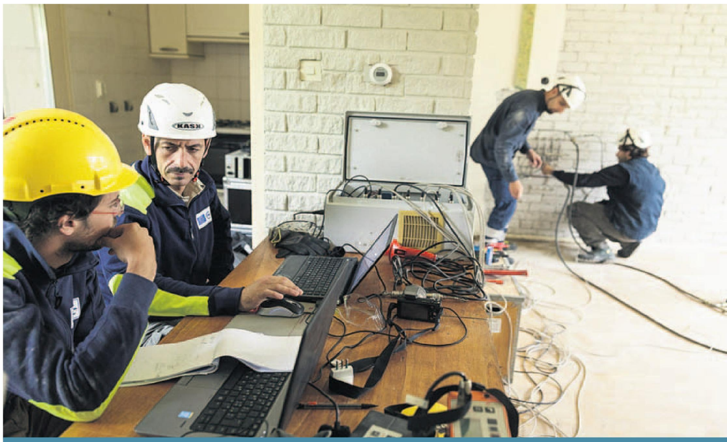
Onderzoekers meten in een testwoning in Loppersum de sterkte van het metselwerk.
