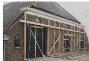
De schade in het aardbevingsgebied in Groningen is enorm. De foto's uit Roodeschool en Bedum spreken boekdelen. Foto's: Schokkend Groningen
