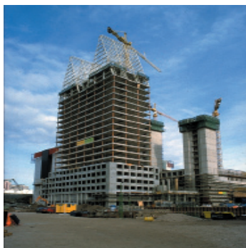
Figuur: Castalia Den Haag, hergebruik van het staalskelet.
