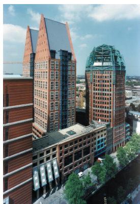
Figuur: Castalia Den Haag, hergebruik van het staalskelet.
