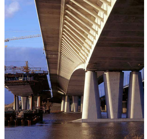
Derde Lekbrug Vianen
